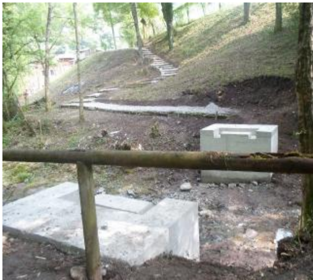
I lavori già iniziati per l'allestimento dei percorsi nell'area verde
